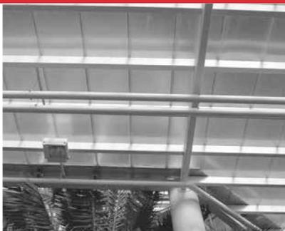
Les plaques ONDUCLAIR® PCMW sont constituées de résine de polycarbonate alvéolaires. Les plaques ONDUCLAIR® PCMW sont utilisées pour la réalisation des parties éclairantes des toitures dans les bâtiments d'habitations ou tertiaires.
